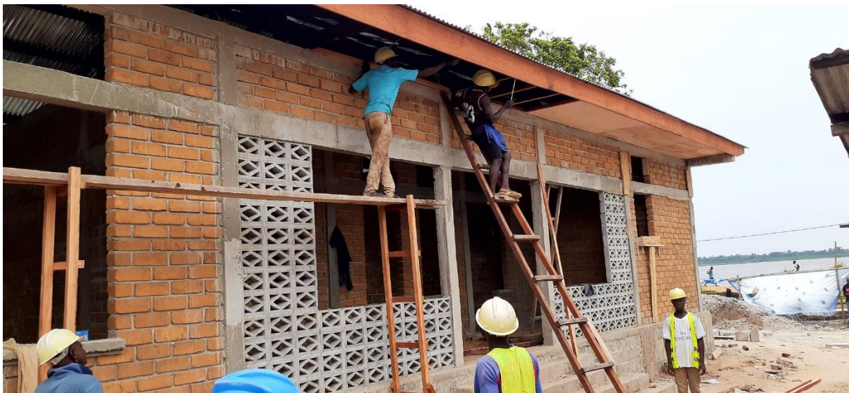
IMAGE 2 BÂTIMENT RÉHABILITÉ DE SERVICES TECHNIQUES DÉCONCENTRÉS DU TERRITOIRE DE BUMBA
